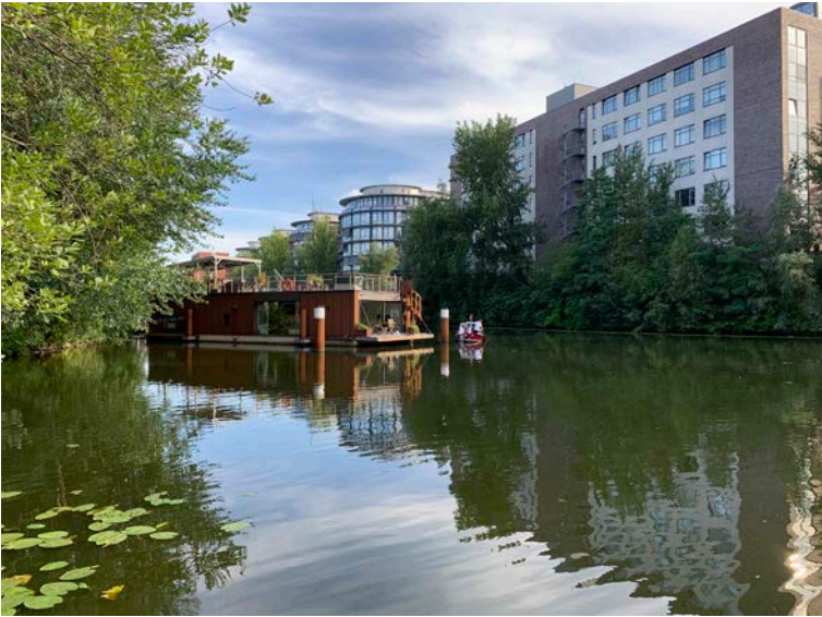
Abb. 7 Hochwasserbassin mit gemischter Bebauung und Hausbooten 2022
