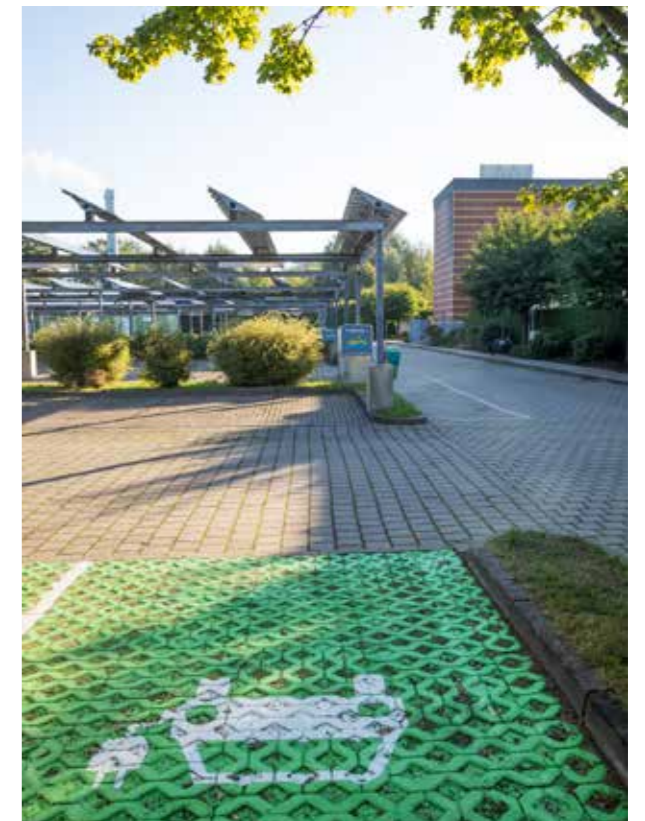
PARADEBEISPIEL ↑ Eine der größten Photovoltaik-Anlagen Norddeutschlands überspannt einen Teil der Parkplätze des ARRIBA Erlebnisbades in Norderstedt. Es gibt auch eine Tanksäule für Elektroautos.
