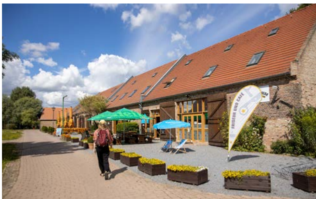
Abb. 96: Scheunenviertel in Kremmen
