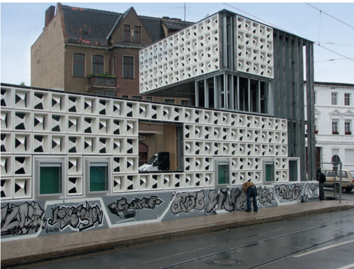
Das Lesezeichen kurz vor der Fertigstellung
