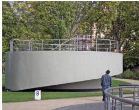
Die erhöhte Notausstiegsplattform, die über einen Tunnel mit dem Westhafen-Tower verbunden ist, ermöglicht im Hochwasserfall den sicheren Ausstieg (Foto: bgmr Landschaftsarchitekten).
