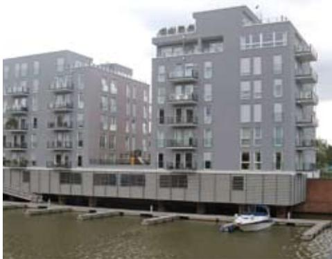
Mit flutbaren Sockelgeschossen, die als Garagen genutzt werden, wird der Retentionsraumverlust im Westhafen minimiert (Foto: bgmr Landschaftsarchitekten).
